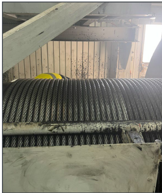
Bęben linowy - lina z lewej już wyczyszczona i nasmarowana, z prawej jeszcze przed obróbką.
