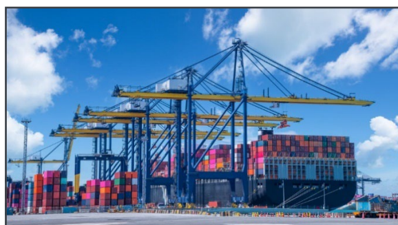
Dźwigi STS (statek-brzeg) w porcie - środowisko pracy lin stalowych.
