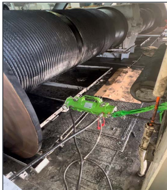
Viper WRL Mid przy bębnie linowym: czyszczenie liny i nakładanie nowego smaru podczas nawijania.
