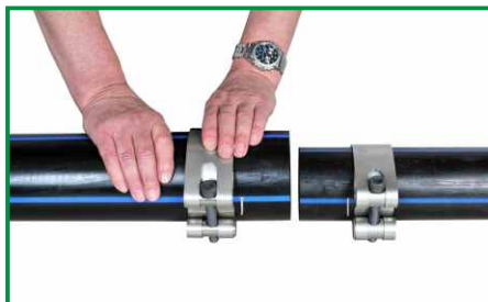
Nasunąć obejmy na rury do połączenia.
