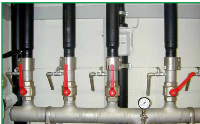
Połączenie rurociągów z PE z rurami ze stali szlachetnej.
