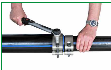
Śruby obejm dokręcić za pomocą klucza dynamometrycznego aż do danego momentu dokręcającego.
